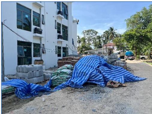
ภาพถ่ายที่ 2.1-2 ผ้าใบคลุมวัสดุที่เกิดฝุ่นละออง เช่น ปูนซีเมนต์ เศษวัสดุก่อสร้าง
