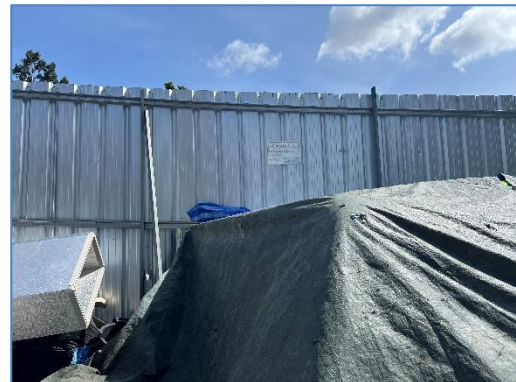
ภาพถ่ายที่ 2.1-2 ผ้าใบคลุมวัสดุที่เกิดฝุ่นละออง เช่น ปูนซีเมนต์ เศษวัสดุก่อสร้าง
